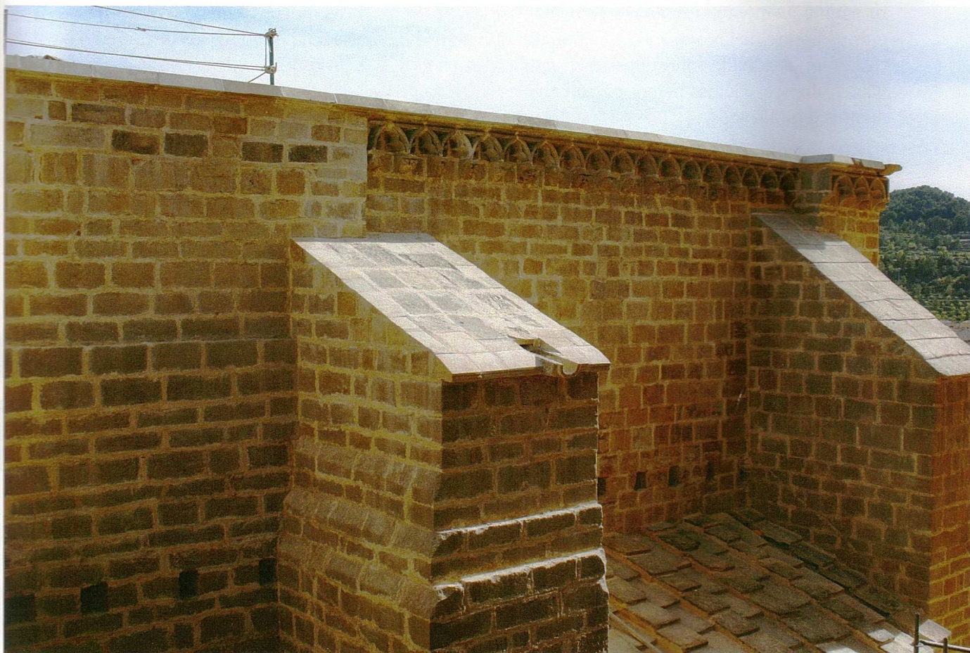
Muro norte de la iglesia, ya restaurado
